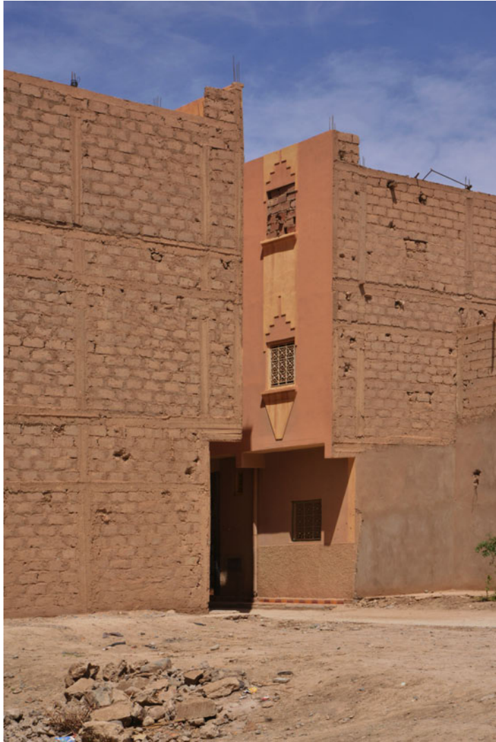
Rissani , nouvelles constructions 2015
