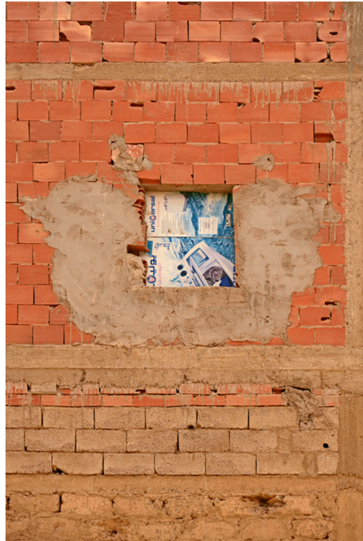
Rissani , détail fenêtre 2016
