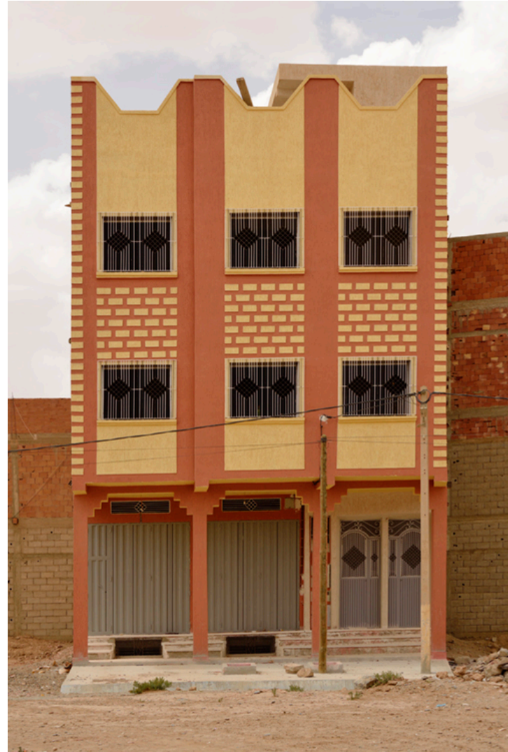
Rissani , nouvelles constructions 2018
