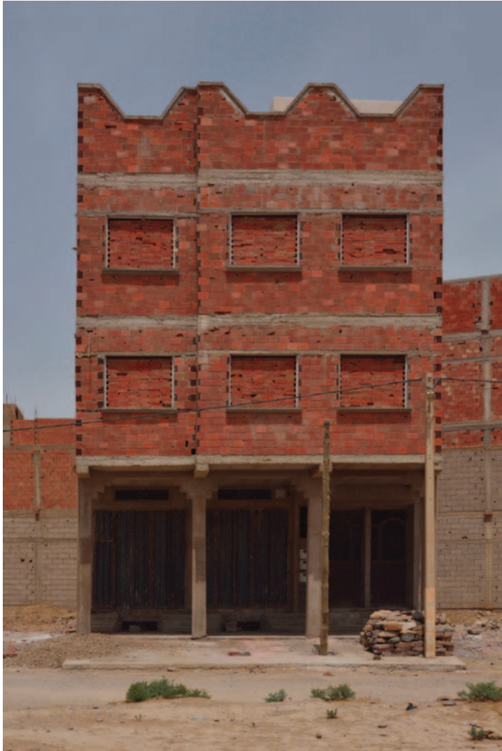
Rissani , nouvelles constructions 2016
