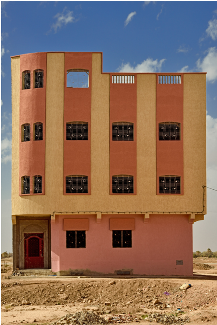
Rissani , nouvelles constructions 2016
