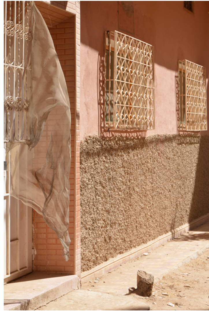
Rissani , nouvelles constructions , rue 2012
